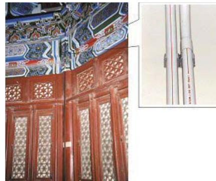
Uma instalação inteligente da tubagem, adaptando-a às formas artísticas do edifício, tornam o sistema de detecção de fumo quase invisível.
